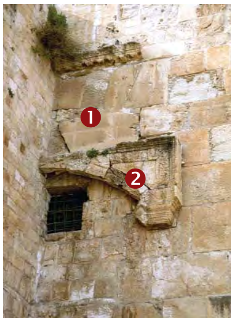
Abb. 39 Der originale Sturz des rechten Eingangs der Schönen Pforte ❶ originaler Sturz mit darüber liegendem Entlastungsbogen ❷ Sturzverzierung aus islamischer Zeit
