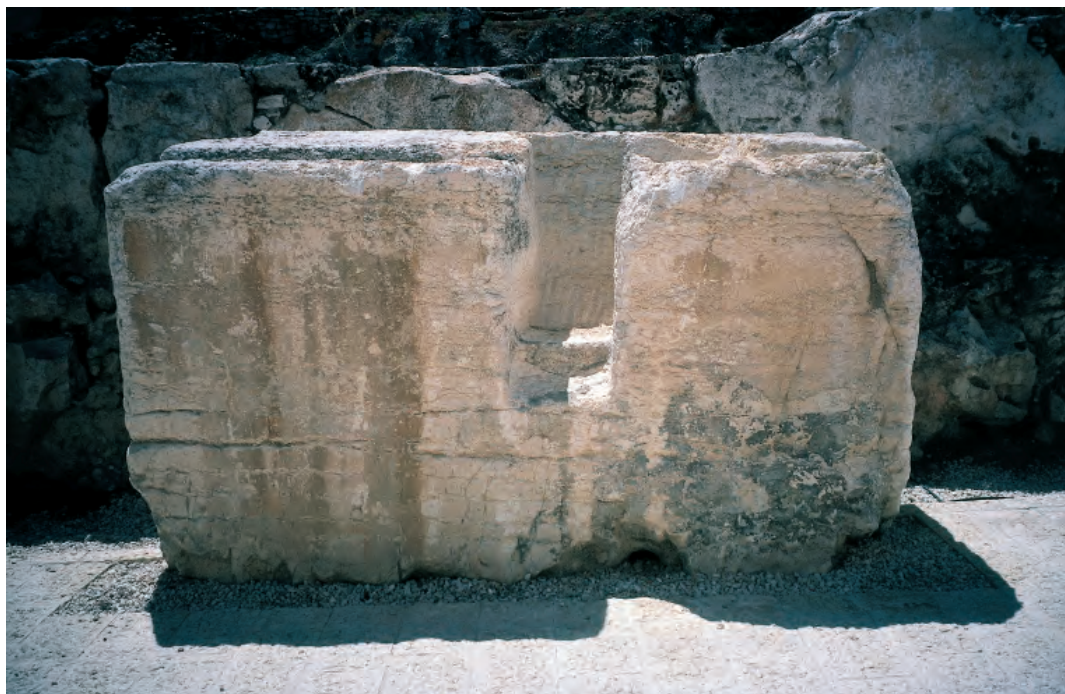
Abb. 160 Unvollendet gebliebenes Baumaterial. In den vorbereiteten Zwischenraum sollten Holzbalken eingelegt werden, die nach Übergießung mit Wasser eine Sprengung auslösen sollte, sodass aus diesem Felsblock zwei Bausteine hätten entstehen sollen.
