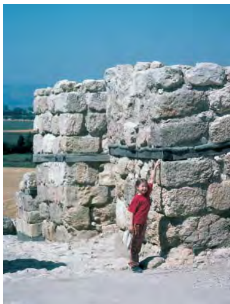
Abb. 19 Stadt-Tor aus Stratum VII in Megiddo. Elda Liebi (6-jährig) weist auf die vor Erdbeben schützende Entlastungsschicht hin.
